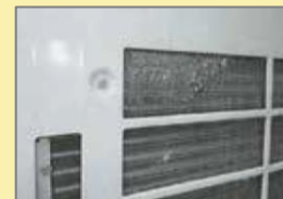
室外機にゴミが付着
