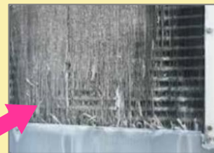
室外機の腐食
