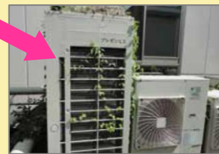
室外機が草で覆われている
