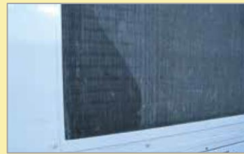
熱交換器の油のにじみ
