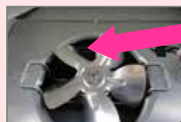
ファンとの隙間から熱交換器の油のにじみや霜付きなどの確認
