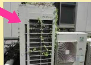
室外機が草で覆われている
