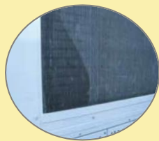
熱交換器の油のにじみ
