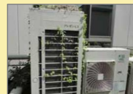
室外機が草で覆われている
