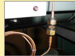
圧力検知配管の油のにじみ
