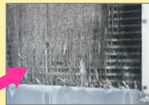
室外機の腐食
