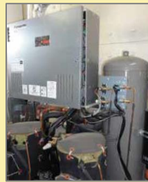
機械室内部にある冷凍機
