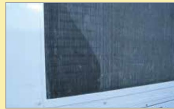
熱交換器の油のにじみ
